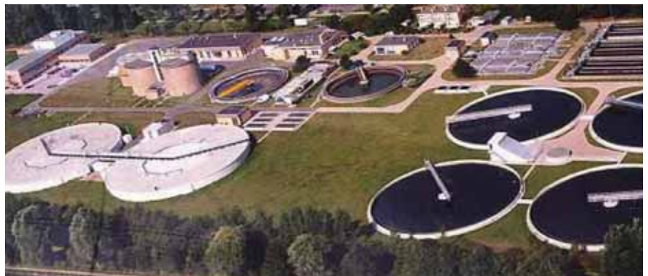
De rioolwaterzuiveringsinstallatie Leiden-Zuidwest.
