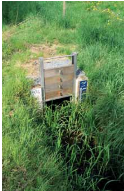
liggen op een diepte van 80 tot 120 cm onder het maaiveld. Door buisdrainage blijft het peil van het grondwater continu (te) laag.
